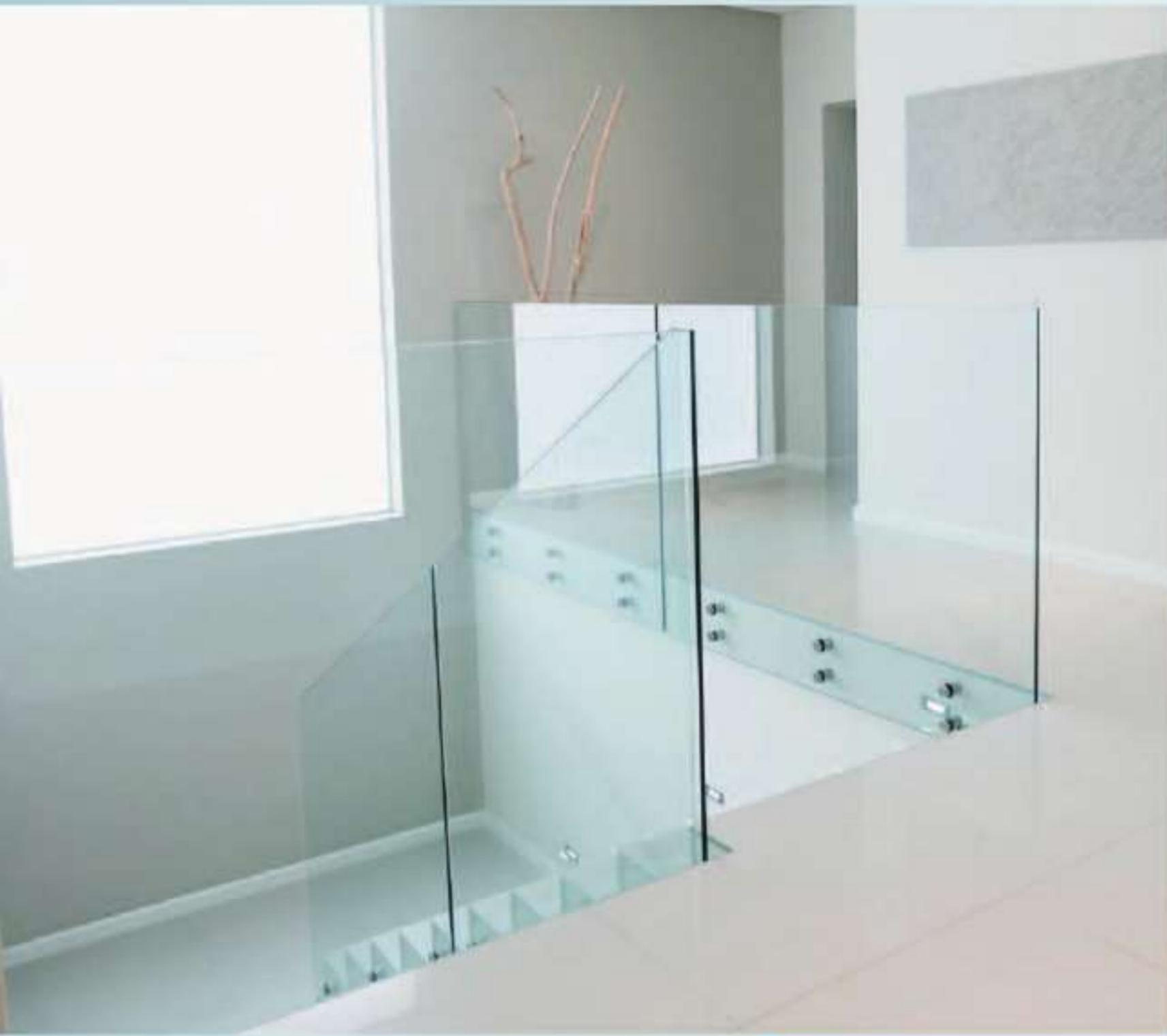
AK61 Cam Adaptörleri tamamen çerçevesiz dikey direkleri ortadan kaldırır sistemlerdir. Duvar ile bütünleşen bağlantısıyla bir bütünlük ve kesintisiz görünüm sağlar. İç ve dış mekanlarda camın zarafetini on plana çıkartarak her duvara uyum sağlar.
